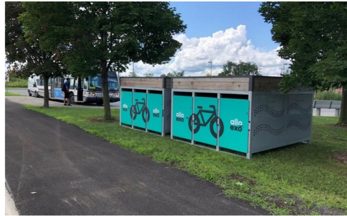
Fig.64. Abri pour vélo de la gare Sainte-Rose, Laval, Canada Source : EXO Québec
