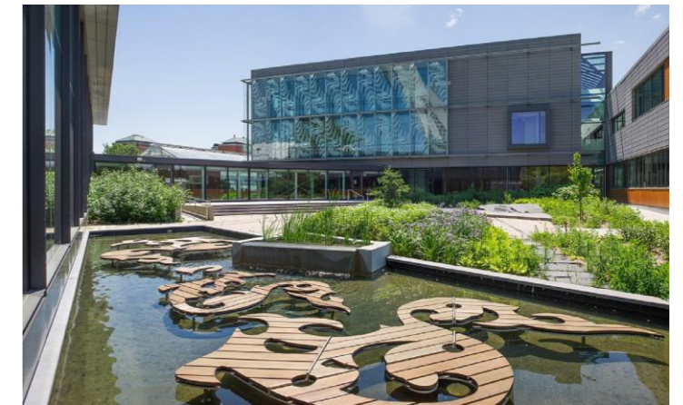
Fig.84.Bassin de rétention du campus d'Outremont, Montréal, Canada Source : Provencher_Roy
