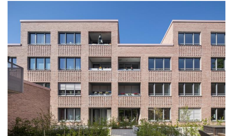
Fig.95.Bâtiment résidentiel, Münster, Allemagne Source : FRML
