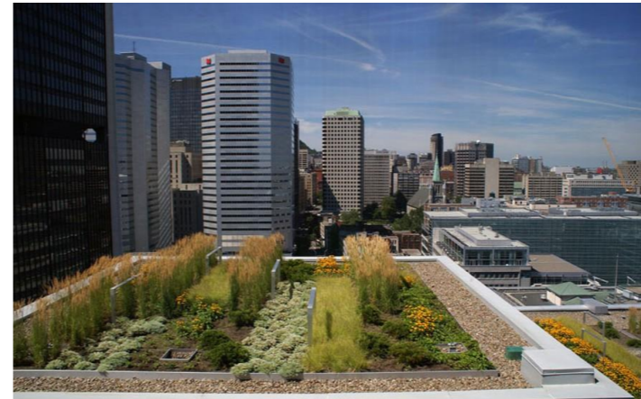
Fig.116.Toiture végétalisée Québec, Montréal, Canada Source : Les toits vertiges
