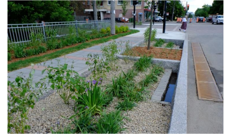
Fig.81.Jardin de pluie sur la rue Mountains Sights, Montréal, Canada Source : Catalyseur urbaine
