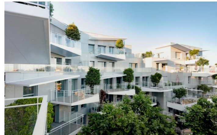
Fig.118.Terrasses végétalisées, Montpellier, France Source : Valode & Pistre Architectes
