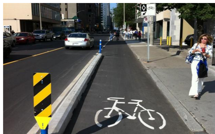
Fig.59. Voie cyclable unidirectionnelle sur chaussée, Montréal, Canada Source : The Centre of Active Transportation
