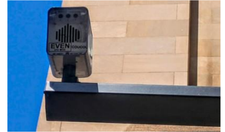
Fig.127. Dispositif de signal sonore aux intersections Source : Ville de Montréal
