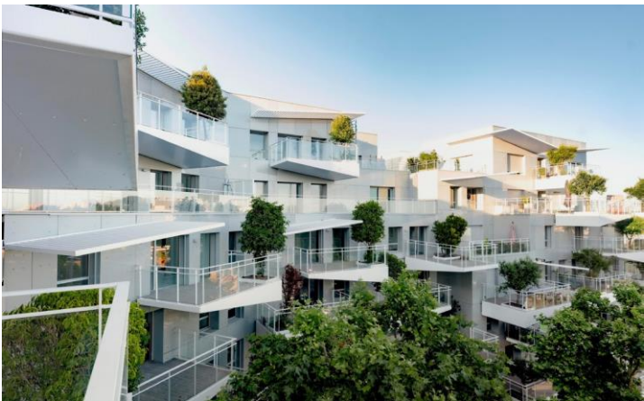
Fig.118.Terrasses végétalisées, Montpellier, France Source : Valode & Pistre Architectes
