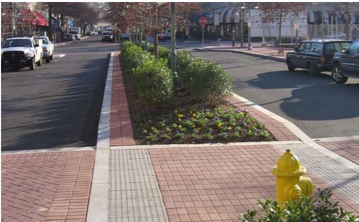
Fig.77.Traverse piétonne avec îlot central, Arlingtonva, É-U Source : NACTO
