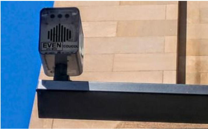
Fig.127.Dispositif de signal sonore aux intersections Source : Ville de Montréal
