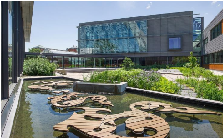
Fig.84.Bassin de rétention du campus d’Outremont, Montréal, Canada Source : Provencher_Roy
